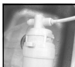
5. Вставьте трубку в разъем гнезда. Поверните кран врезки, чтобы промыть фильтр.
